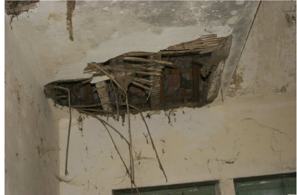
Faux plafond à enlever
