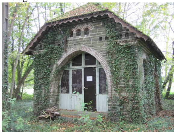
Bâtiment des pompes
